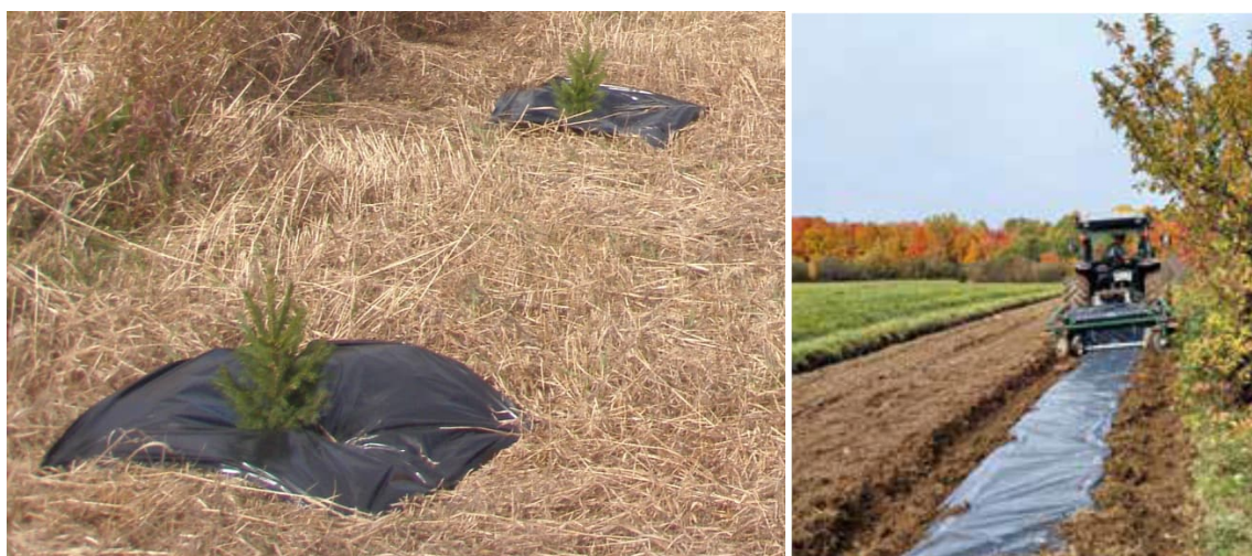
Figure 3- Paillis installé après (à gauche) et avant (à droite) la plantation des végétaux
